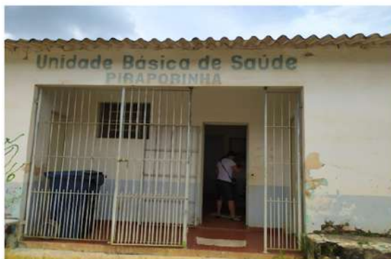
Figura 1 - Ampliação do atendimento na UBS do Bairro Piraporinha.
